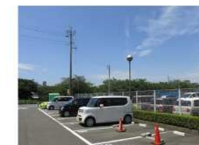
二川駅南口自転車等駐車場（西エリア）の駐車管制設備
